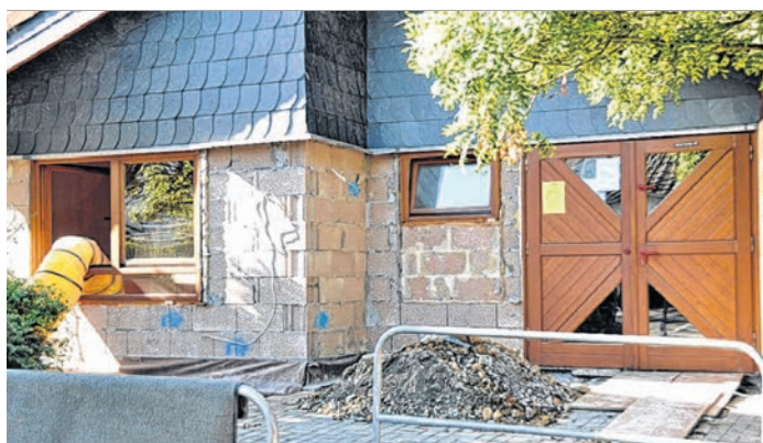
Sanierungsarbeiten am Eingang der »Sternschnuppe«.
